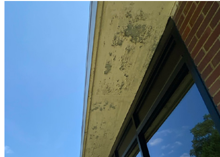
02 degrading soffit
